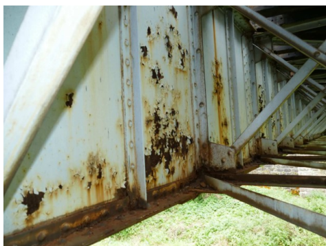
Obr.č.3,4 - Korozní oslabení prvků OK
